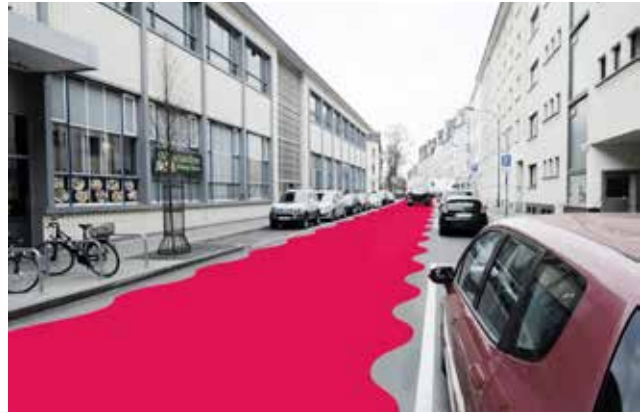
Abb. 71 Flächig rote Fahrbahn mit Wellenkontur
