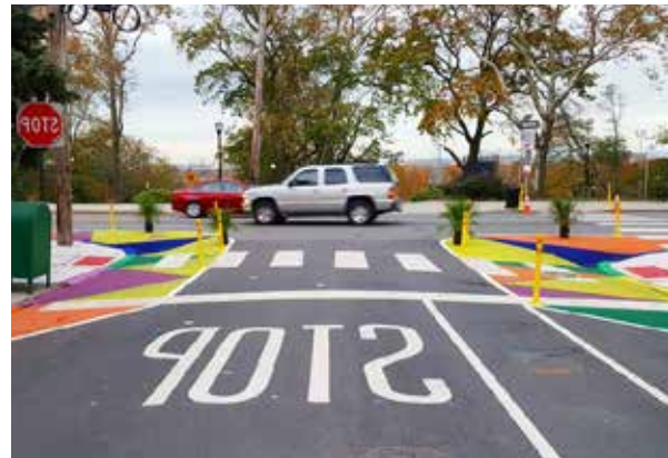
Abb. 44 Fahrbahnverengung, Jersey, USA
