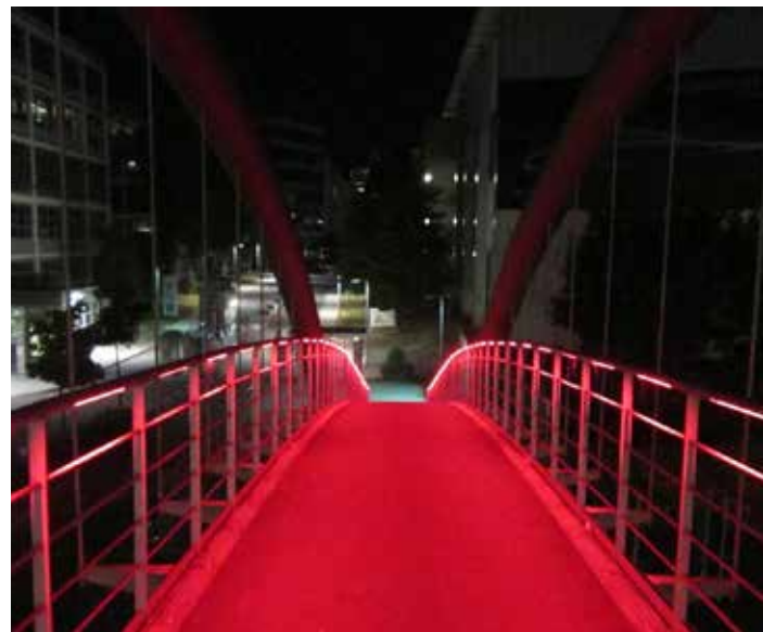
Abb. 119 Beleuchtete Fahrrad- und Fußgängerbrücke
